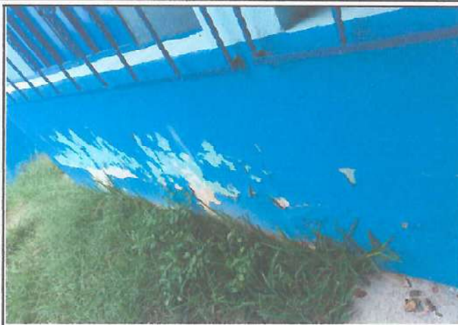
Foto 2: Pintura en todas las instalaciones interior y exterior
