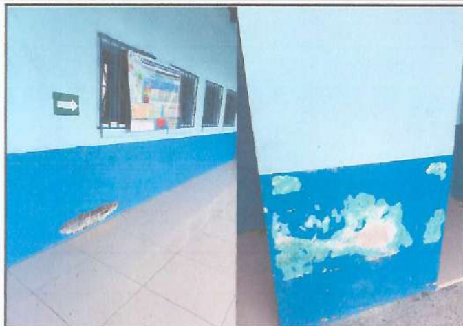
Foto 1: Reparación de repello y cernido de paredes interior y exterior.
